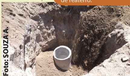
É preferível que os anéis sejam colocados por meio da retroescavadeira e, a cada anel instalado, seja realizado o reaterro da área do entorno para facilitar a instalação dos próximos. O poço deve ficar cerca de 0,8 m acima da superfície do solo, sendo estes últimos anéis devidamente rejuntados com argamassa para evitar que as enxurradas danifiquem o
