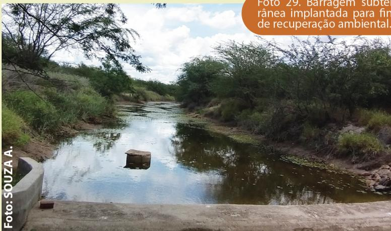
Foto 29. Barragem subterrânea implantada para fins de recuperação ambiental.
