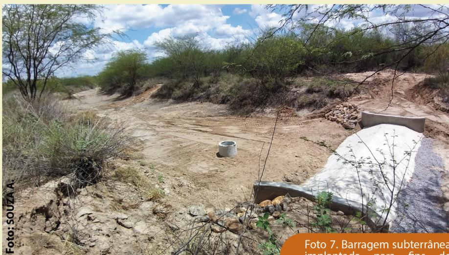
Foto 7. Barragem subterrânea implantada para fins de recuperação ambiental.
