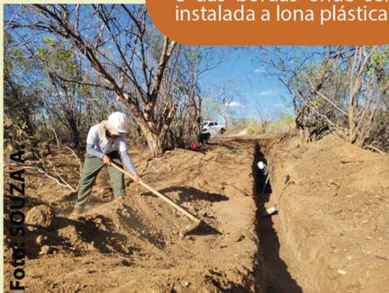
Foto 20. Instalação da lona plástica.
