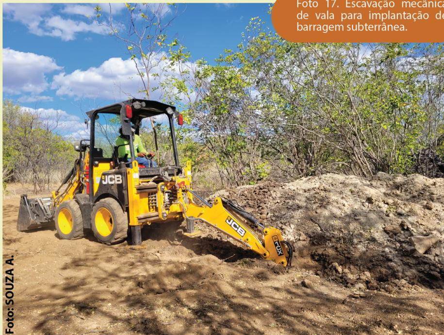
Foto 17. Escavação mecânica de vala para implantação de barragem subterrânea.
